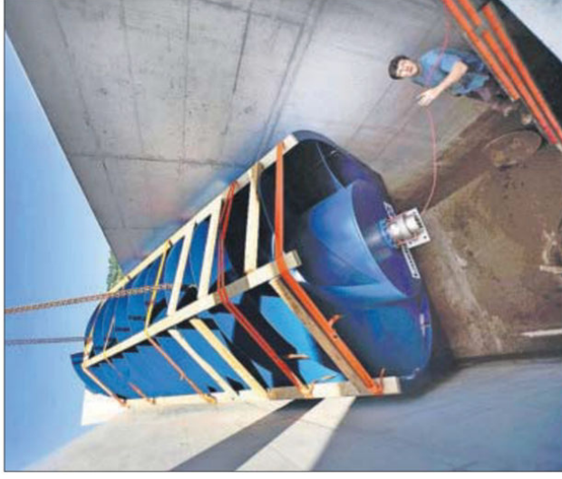
Mit einem Hebekran wird die Wasserkraftschnecke an ihren Platz im Kleinkraftwerk gesetzt.
